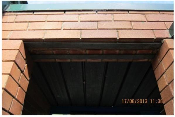
PHOTO 10: CORROSION STEEL LINTELS
